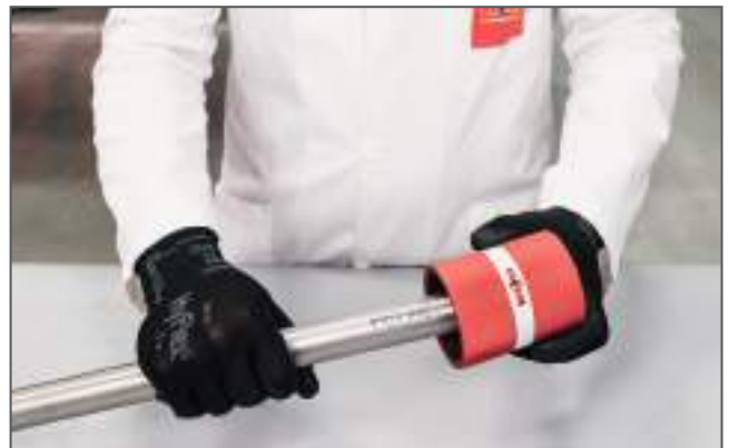
Sbavatura del tubo / Deburring the pipe
